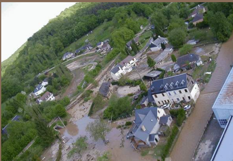
Impasse du Glu le lendemain de la crue du 10 mai 2000 (DIREN)
