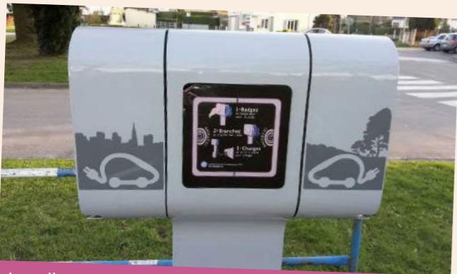
Installation d'une borne électrique - Juin 2017
